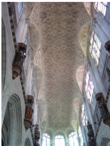
La voûte en caissons de la nef de l'église St-Jean
