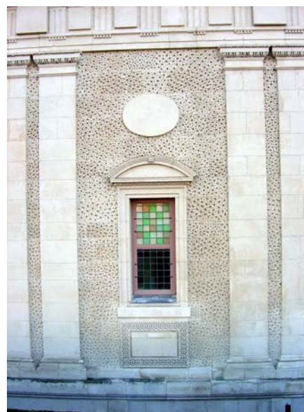
Détail de la façade latérale
