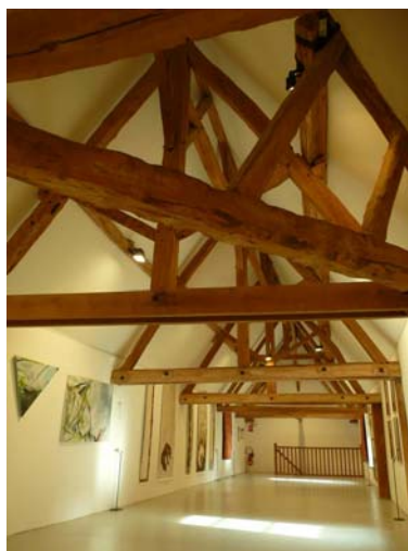
la salle d'exposition et sa charpente
